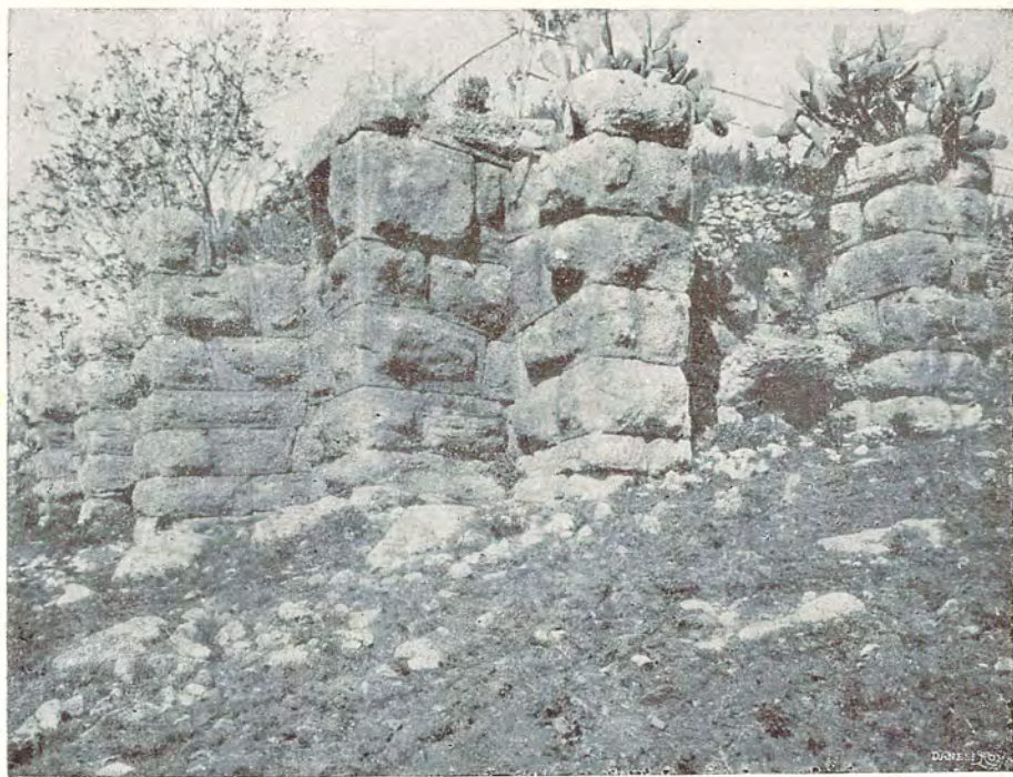
Fig. 16. MURO DI SOSTEGNO DI VILLA A COLLE NOCELLO
