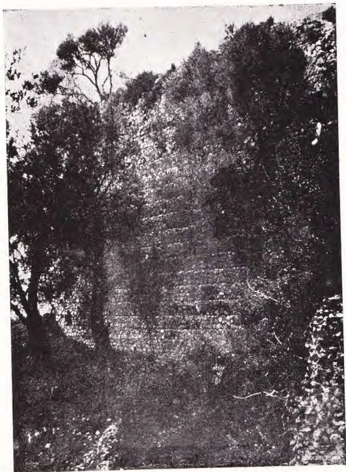
Fig. 8. MURO DI SOSTEGNO DELLA TERRAZZA INFERIORE DELLA VILLA DI QUINTILIO VARO
