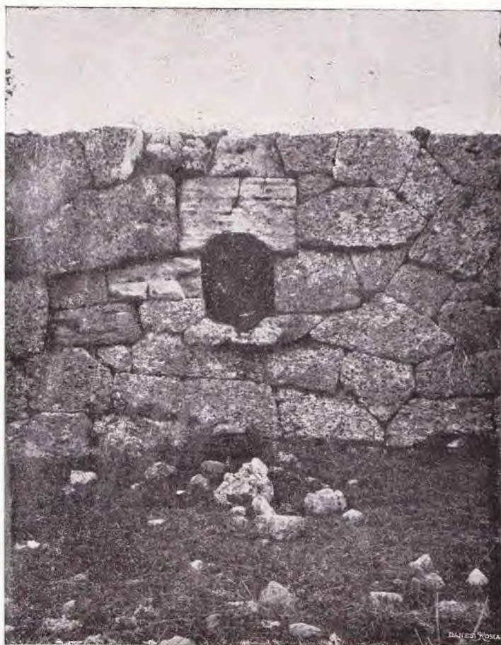
Fig. 13. CUNICOLO NEL MURO DI SOSTRUZIONE DI UNA VILLA AL COLLE CIGLIANO
