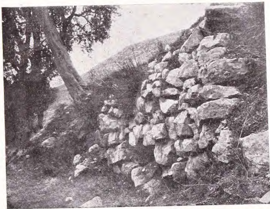
Fig. 10. MURO DI SOSTEGNO DELLA STESSA VIA
