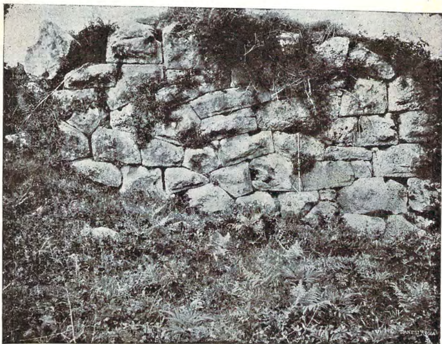
Fig. 19. — MURO DI SOSTEGNO DI VILLA AL COLLE DEL TESORO
