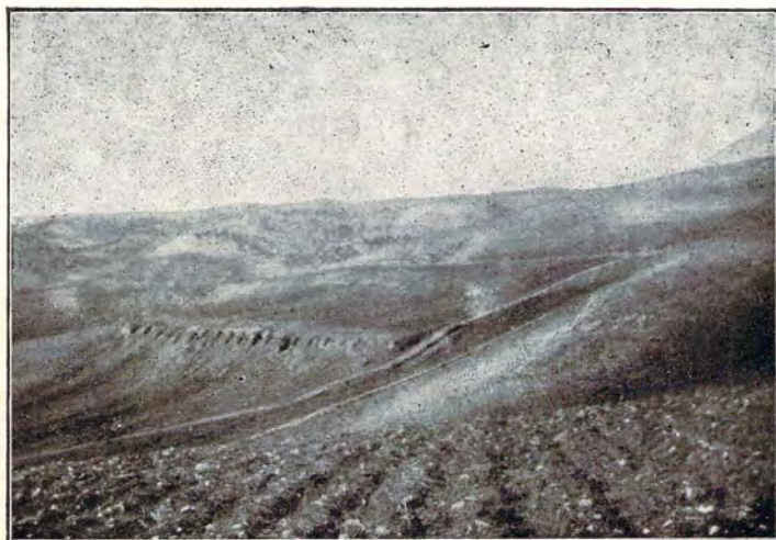
Fig. 22 — SOSTRUZIONE DI VILLA AL COLLE DELLE COLONNELLE
