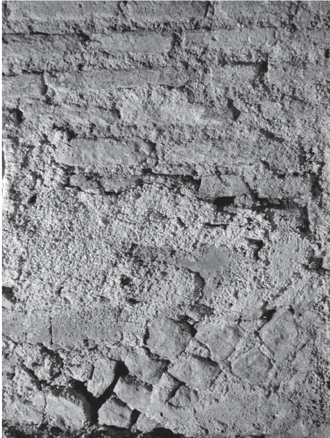
Fig. 10 - Cubilia nell'ambiente del bagno.
