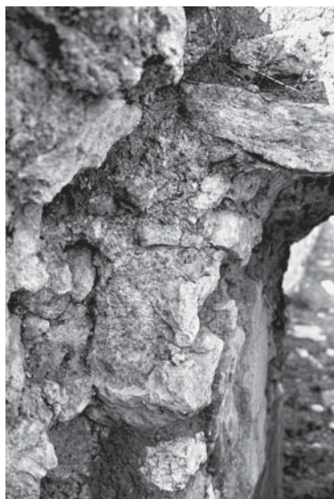
Fig. 9 - Estremità meridionale del canale dell' aulaeum , particolare della copertura.
