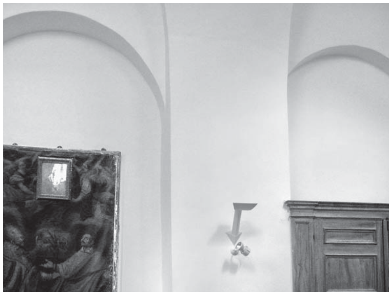
Fig. 14 - Archi tamponati nella parete S della sagrestia dei Beneficiati.
