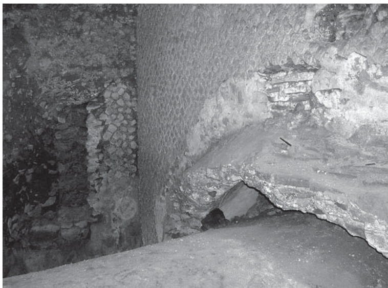
Fig. 20 - Ambiente retroabsidale - muro G e resti dell'absidiola medievale.
