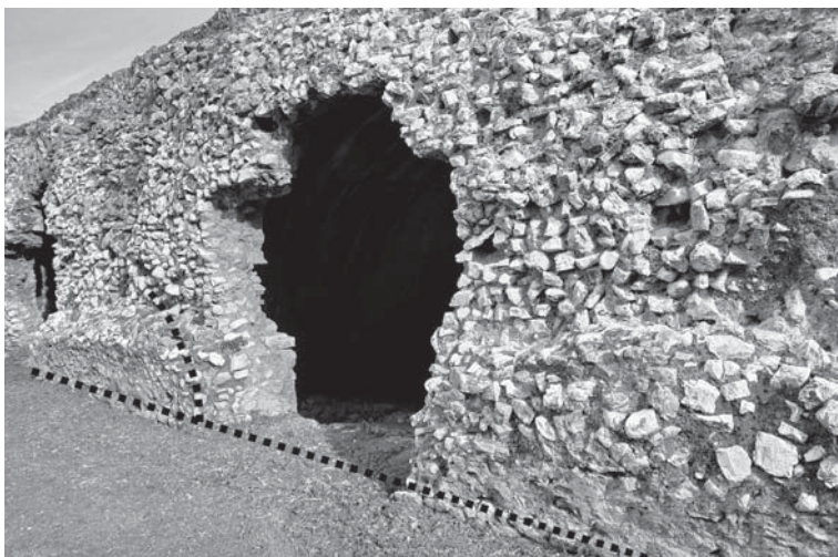
Fig. 5 - Sostruzione scenica con evidenziazione delle tracce riferibili alla volta relativa al percorso antistante.
