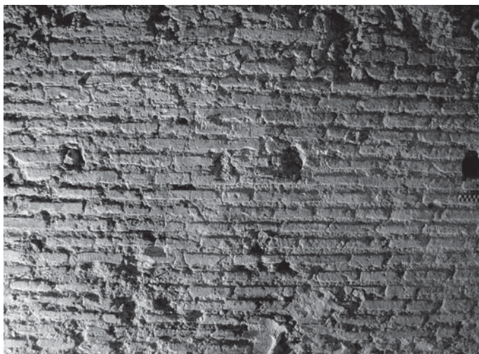
Fig. 5 - Muratura medievale nell'ambiente del bagno.
