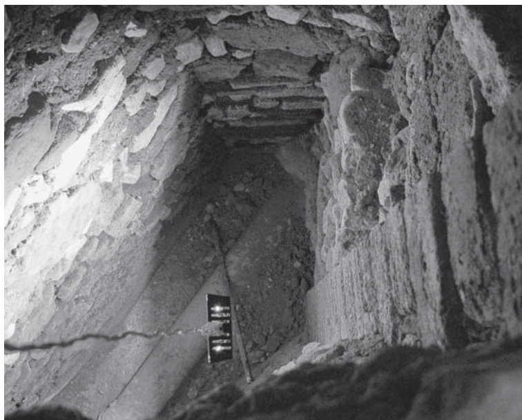
Fig. 11 - Spalletta visibile dalla botola nell'ambiente del bagno.
