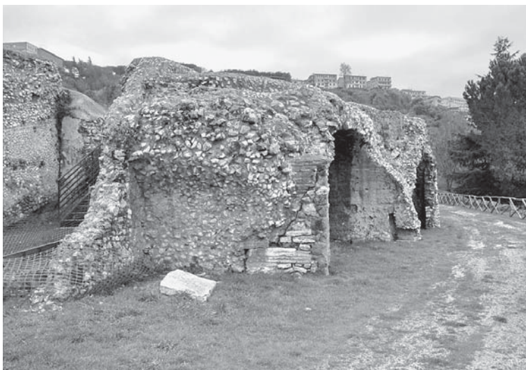
Fig. 3 - Resti di un ulteriore vano nell'estremità settentrionale della sostruzione scenica.
