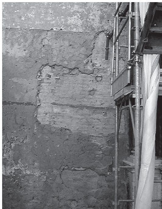
Fig. 6 - Muratura medievale accanto al portone laterale.
