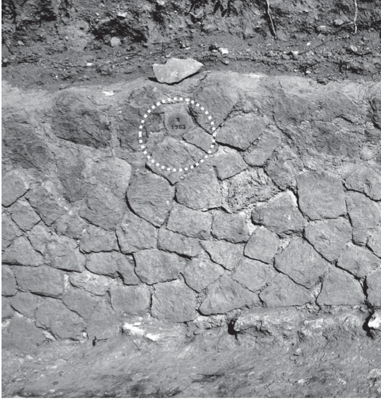
Fig. 17 - Particolare del muro a monte della rampa con indicazione del restauro effettuato nel 1983.
