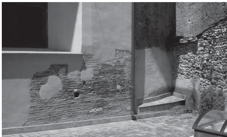
Fig. 15 - Muratura medievale esterna del muro S della navata centrale.
