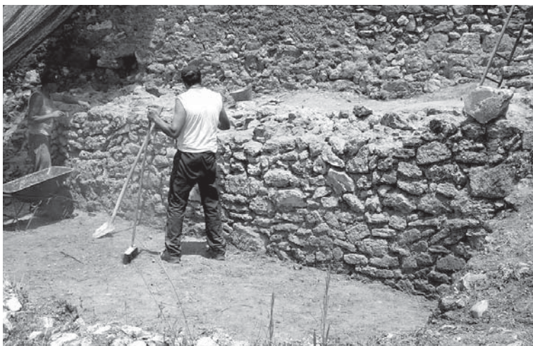
Fig. 15 - Muro rettilineo ai piedi del terrazzamento moderno interessato dai resti del tempio.
