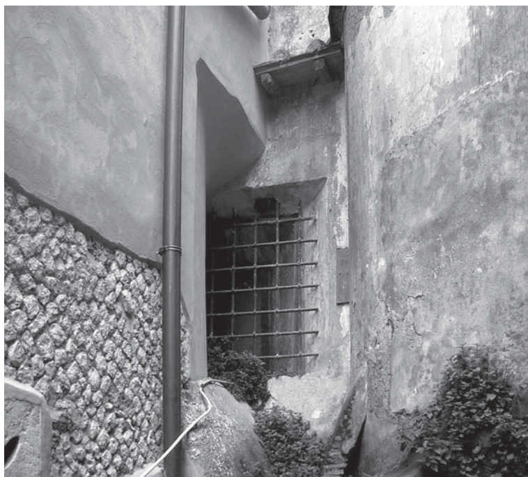
Fig. 7 - Muro S della cattedrale e oratorio del Salvatore.
