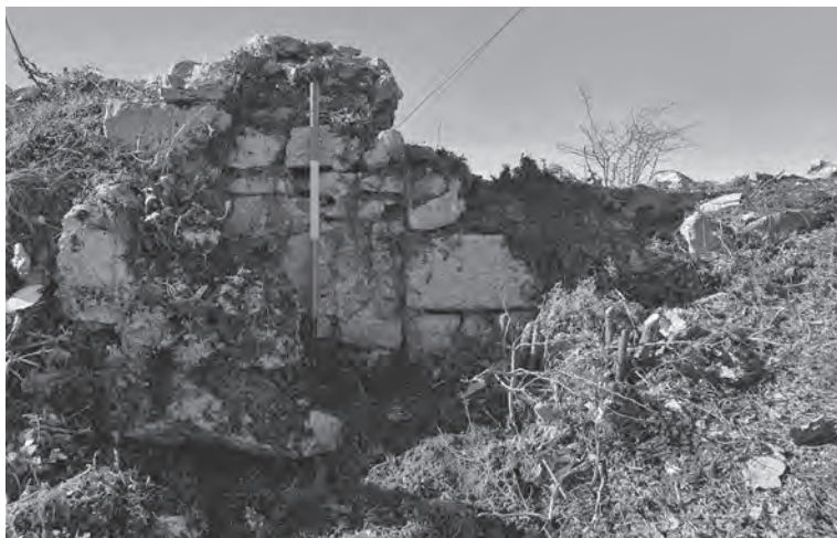
Fig. 10 - Paramento esterno del lato orientale (USM 3) della cappella di San Gennaro (foto: Martina Bernardi).
