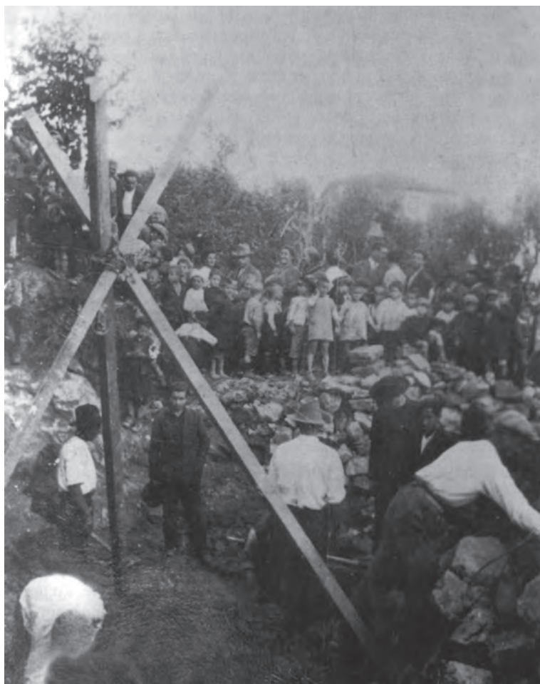
Fig. 15 - Lavori di scavo eseguiti e posa della prima pietra per la costruzione dell'asilo, adiacente all'antica chiesa di S. Maria.
