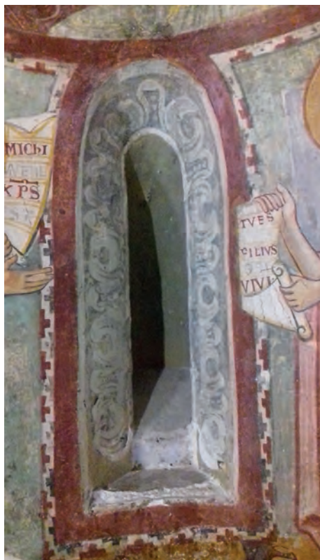
Fig. 7 - Monofora nella Cappella di S. Gregorio chiusa dopo la costruzione dei contrafforti per realizzare l'ingresso dall'alto.
