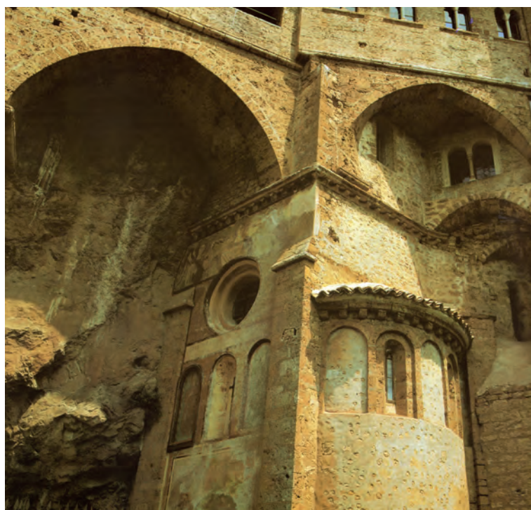
Fig. 6 - Facciata della Cappella della Madonna in corrispondenza del primitivo ingresso a lato del Roseto. Si notano i tre contrafforti.
