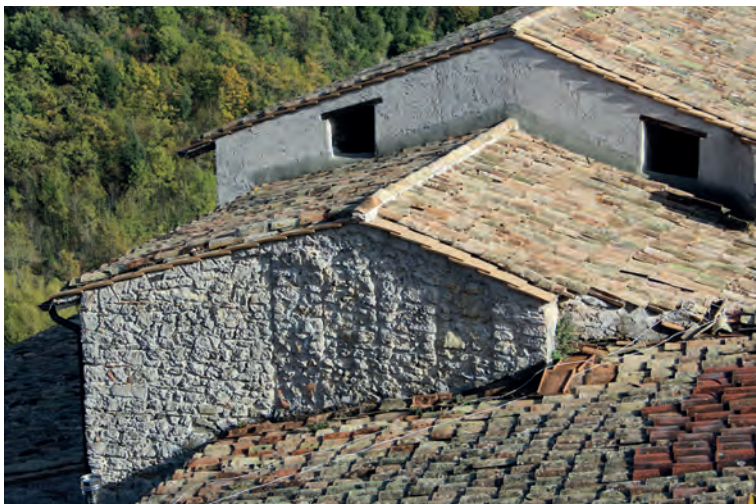
Fig. 1 - Cineto Romano, chiesa di S. Giovanni Battista: impronta di un campanile a vela a doppio arco inglobato nella muratura della parete posteriore, 2021 (foto Alexandro Colasanti).
