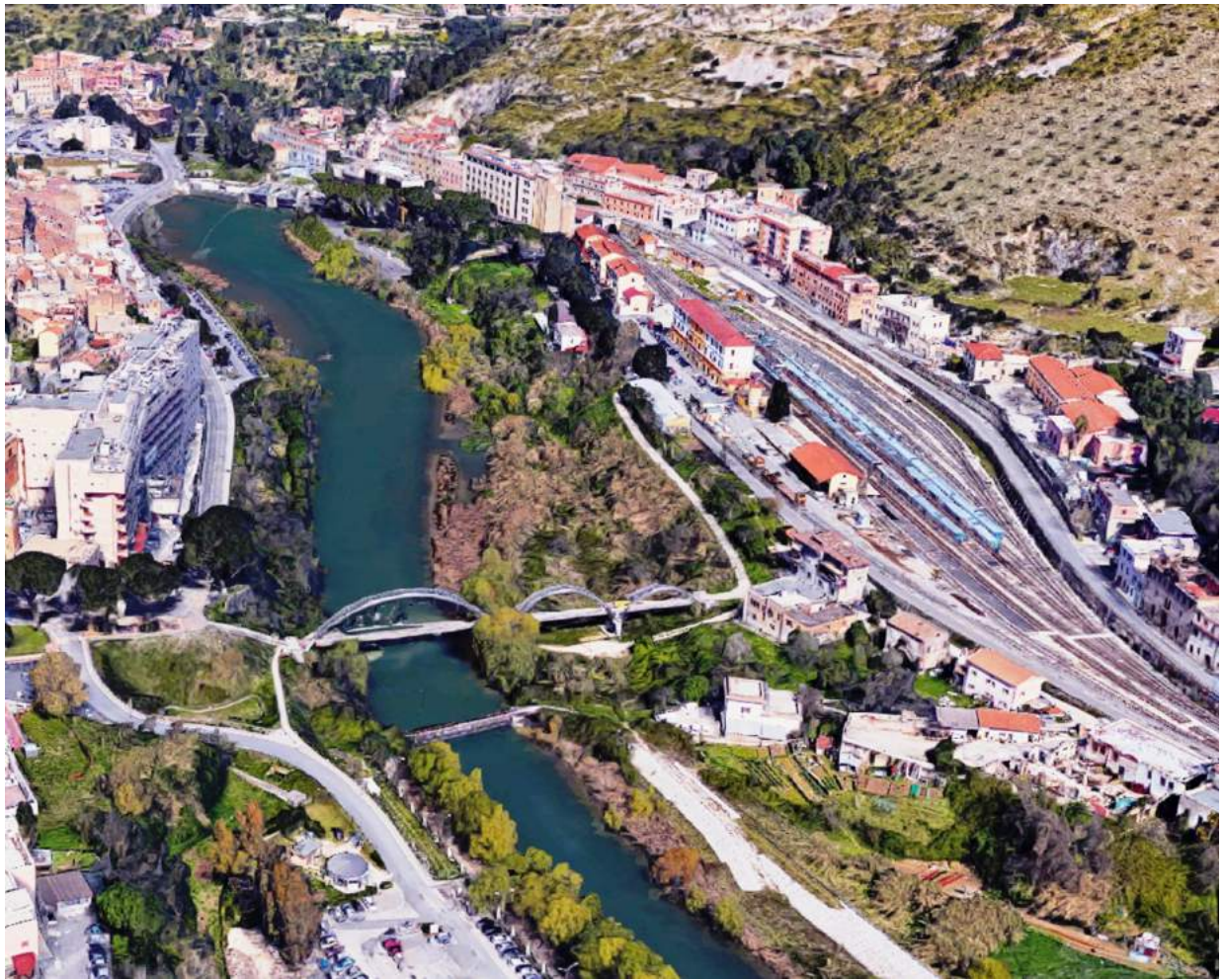
Il ponte della Pace, a tre campate, che collega la zona dell'Ospedale S. Giovanni Evangelista (al centro, a sinistra) alla Stazione Ferroviaria. In basso, sulla sponda sinistra dell'Aniene, l'inizio del parcheggio del Lunganiene Impastato. In alto, alla fine del bacino artificiale di S. Giovanni si vedono la diga di sbarramento e i due cunicoli gregoriani. Nella zona del ponte della Pace esisteva già in antichità un ponte romano, ma naturalmente il letto dell'Aniene era più stretto. Sulla destra la Stazione Ferroviaria.
